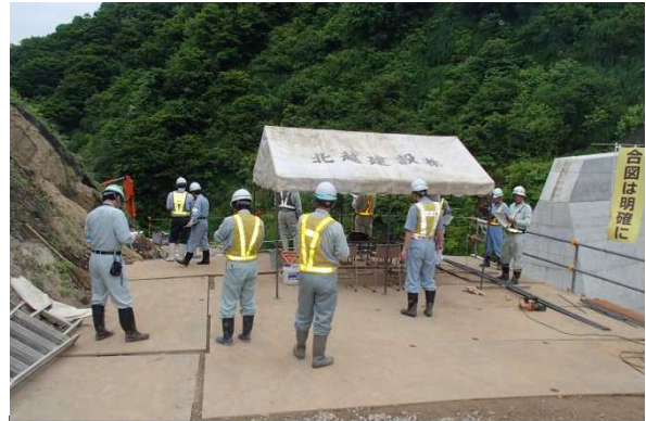
芋川沢第1号砂防堰堤その3工事
