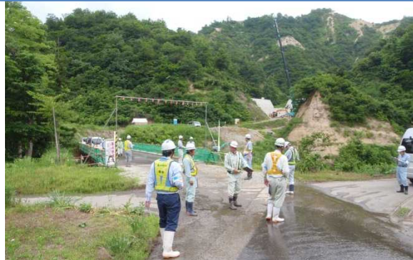
十二平下流砂防堰堤その2工事
