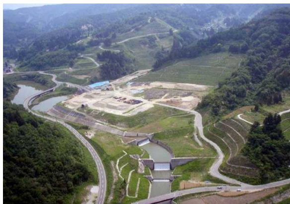
砂防施設の整備 平成18年6月10日
