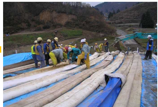
緊急排水ルート付替設置状況 平成16年11月18日
