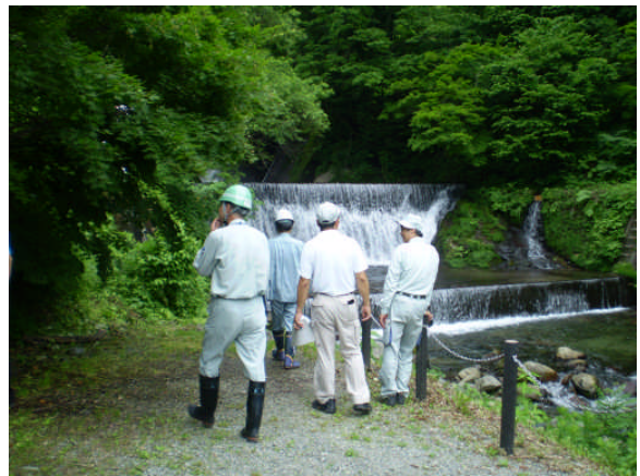
■板木砂防堰堤
