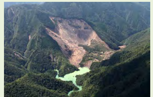
奈良県十津川村栗原に生じた深層崩壊と土砂ダム
