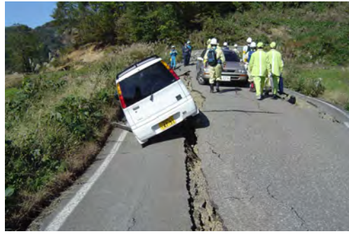
②土砂災害危険区域緊急点検開始 (2004.10.27)
