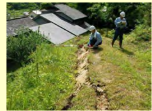
危険箇所点検の様子
