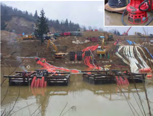
③湯沢砂防事務所が新潟県から河道閉塞対策を引き継ぎ、ポンプ排水を行う (東竹沢地区 2004.11.5～)
