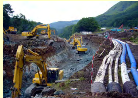
土砂ダムの対策工事（ポンプ排水を行いながら水路を掘削中 岩手県一野々原地区）
