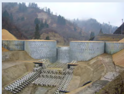
神沢川砂防えん堤
