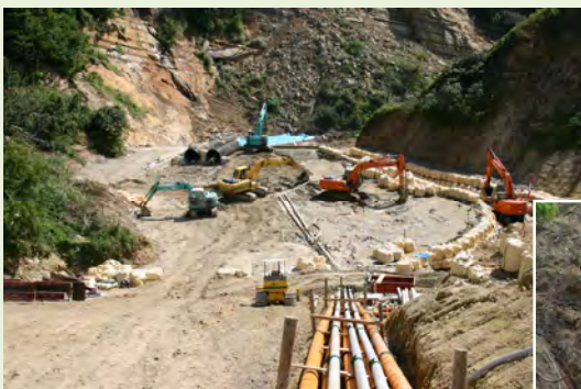
パワーブレンダーによる寺野地区での砂防えん堤建設現場の地盤改良
