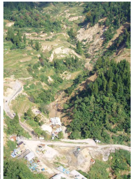
東川地区砂防えん堤建設地と上流の状況
