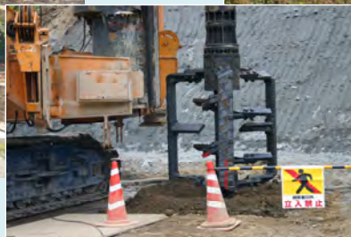
深層攪拌処理工法による東竹沢地区での砂防えん堤建設現場の地盤改良
