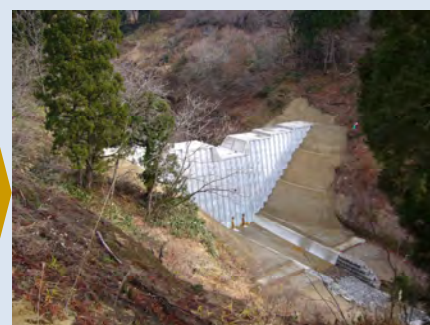
冷子沢川砂防えん堤
