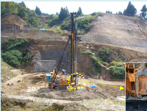
深層攪拌処理工法による東竹沢地区での砂防えん堤建設現場の地盤改良
