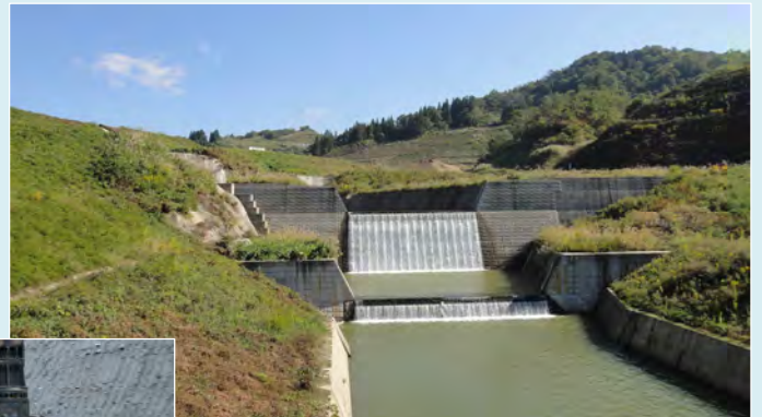
東竹沢1号砂防えん堤
