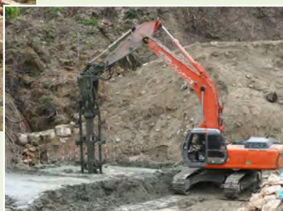
パワーブレンダーによる寺野地区での砂防えん堤建設現場の地盤改良
