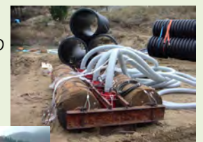
寺野地区で使われたポンプ（4台連結）
