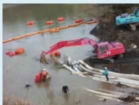
排水ポンプの設置では水中作業も行われた
