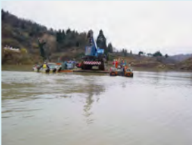
台船で土砂ダム湖を渡る
