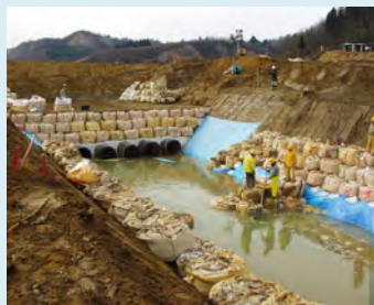
仮設排水管による自然排水
