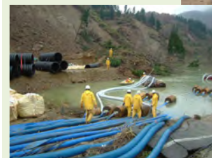
寺野地区でのポンプ排水
