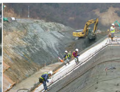
排水路護岸の工事
