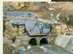
寺野地区の仮設排水管と排水路（上流側）
