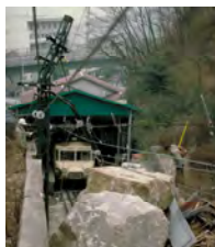
地震で岩が崩れ落ちた兵庫県神戸市灘区六甲ケーブル下駅
