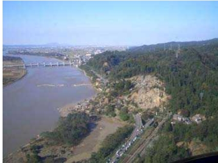
小千谷市妙見地区での岩盤崩壊(10/25撮影)
