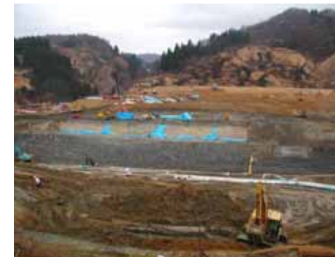
地すべり頭部切土作業(右岸より左岸を望む)
