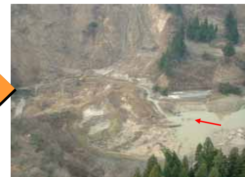
河道閉塞開削状況 12月4日撮影(地震発生32日後)
