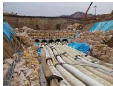
仮設排水管(呑口部)ポンプによる排水状況
