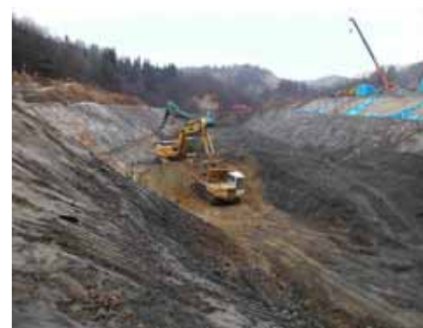
仮排水路施工状況(下流よりより上流を望む)
