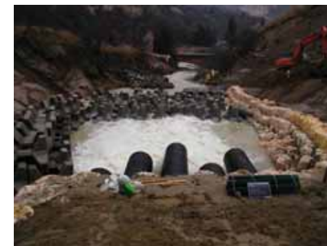
仮設排水管(吐口部)ポンプによる排水状況
