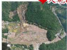
崩壊土砂によって埋没した滝越地区の王滝川ダム跡
