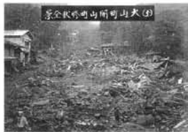
伊勢原市大山町開山町の土石流による被害
