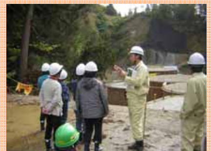
第3回見学会：南平地区の鋼製セル型砂防えん堤工事現場
