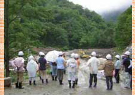
第1回見学会：万太郎谷第4号砂防えん堤工事現場
