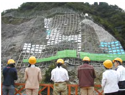
下折立山腹工工事現場の見学
