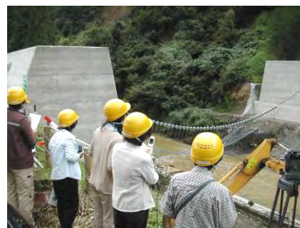
ワイヤーネット砂防堰堤の見学
