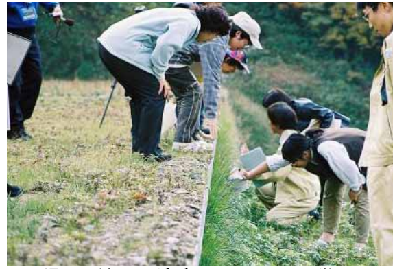
えん堤の天端からダブルウォールを見学。下流側には植生した牧草が育っていました。
