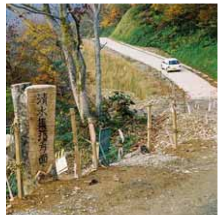
檜倉沢へ続く工専用道路
