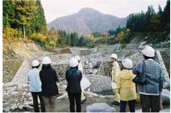
完成している5号床固工と6号床固工(上流側)。こちらを見学すると百聞は一見に如かず。
