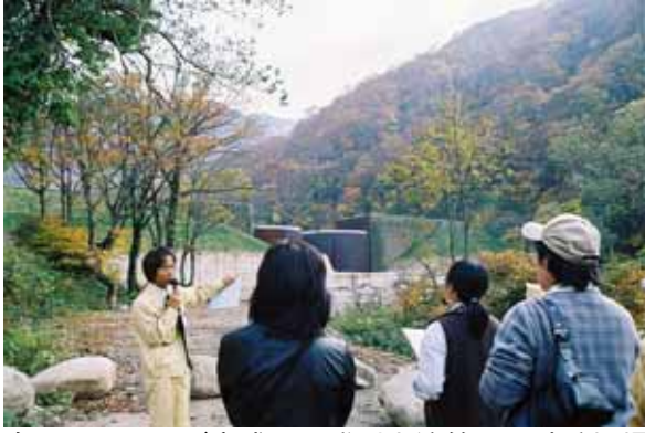
奥に見えるのが完成した登川上流第2号砂防堰堤。担当の中津川出張所の福井出張所長より説明を受けました。
