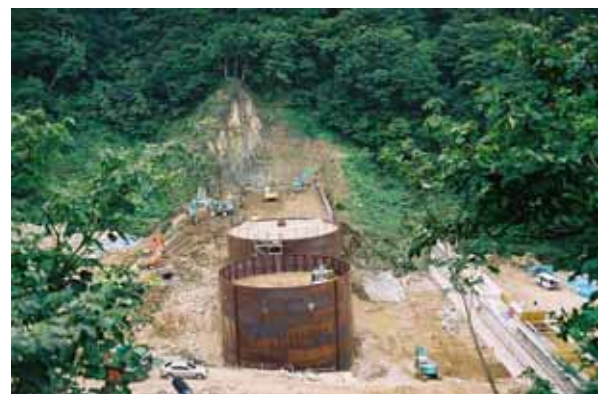
建設中の登川上流第2号砂防堰堤（平成15年9月）
