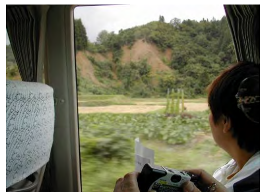
竜光地区へ近づくにつれ、山の崩壊が目立ってきました。
