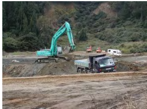
トラック1台で約5㎡の土砂を運びます。
