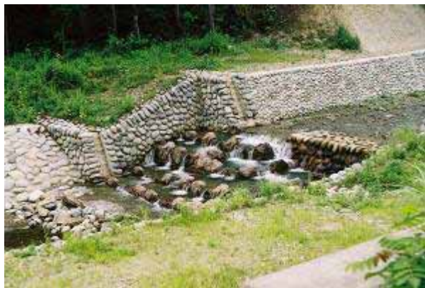
擬岩でつくられた魚道
