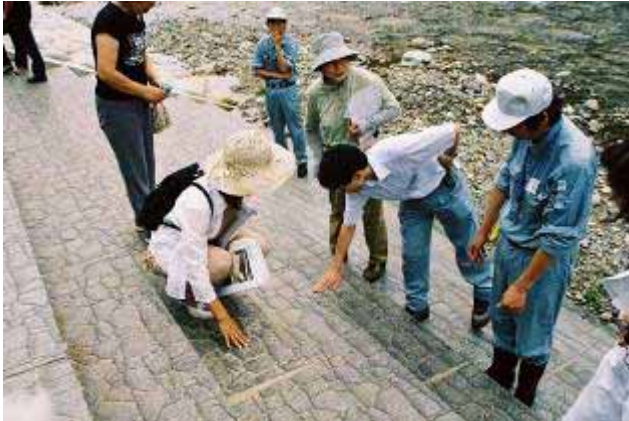
モニターの皆さんが感心した階段護岸(十日町の織物屋のデザインによる型枠コンクリート製)
