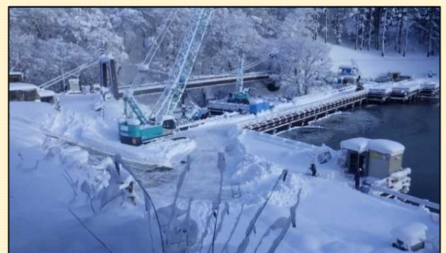
工事現場の様子
