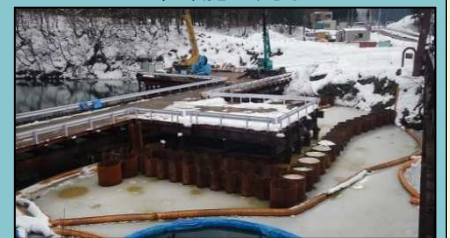
左岸部施工完了
