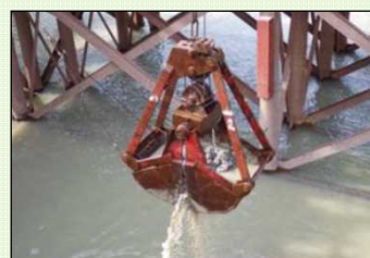
クラムシェルによる掘削(他現場の写真)
