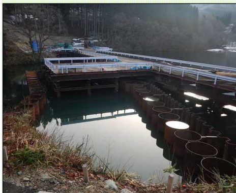
左岸側の鋼管が完了した仮締切(30年3月撮影)
