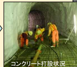
コンクリート打設完了
