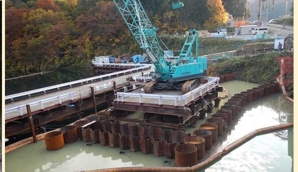
仮締切 鋼管杭施工完了
