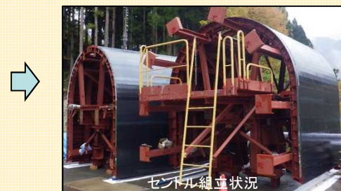
セントル組立状況
