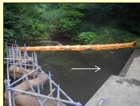
谷後取水堰堤の処理状況(オイルフェンス設置)
