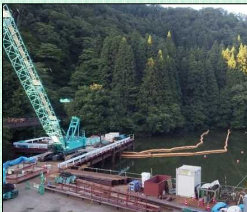
濁水防止フェンスを右岸側へ移設
