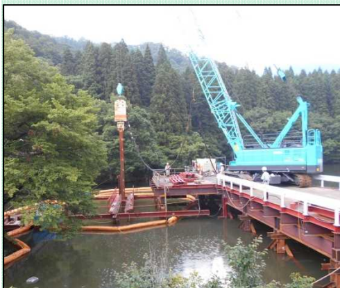
仮締切用栈橋の基礎杭打ち込み状況
