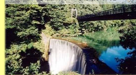
大源太川第1号砂防堰堤
