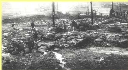
昭和10年 湯沢町での土砂氾濫状況
