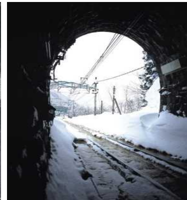
清水トンネル
