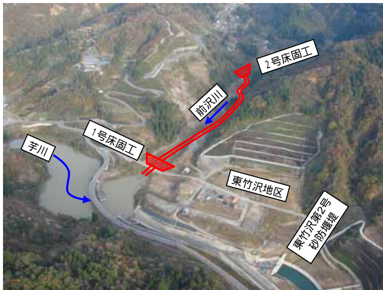
前沢川溪流保全工
