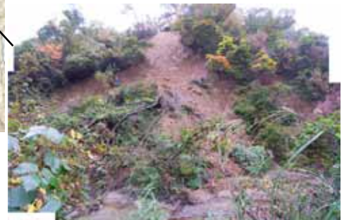
仙之沢川中流の荒廃状況
