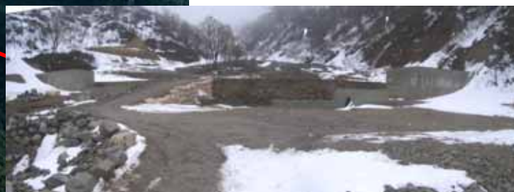
檜倉沢第1号砂防堰堤(施工中)
