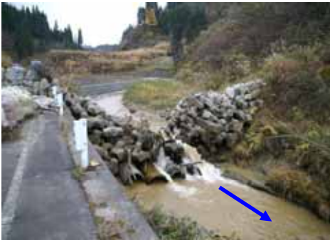
相川川溪流保全工
