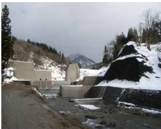
守門川下流砂防堰堤(施工中)
