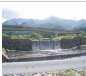
関越自動車道
