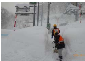
写真13 非常電話の除雪
