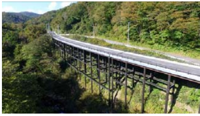
写真4 栈道工の完成
