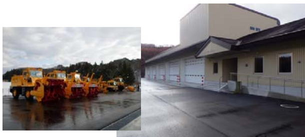
写真9 除融雪機械及び除雪基地
