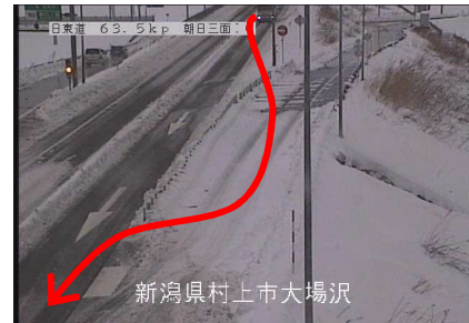
写真-3 ポストコーン設置前の除雪方法
