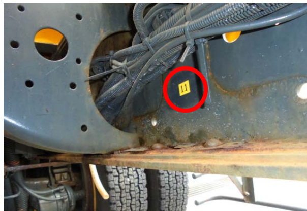
写真-8 シャシフレーム内側
