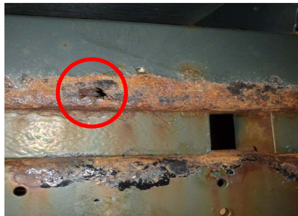
写真-1 シャシ部の孔食状態
