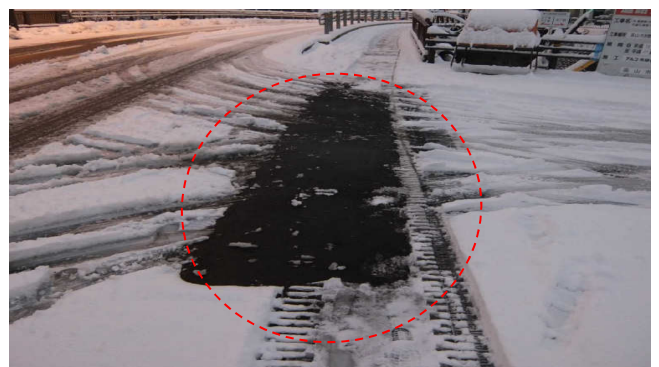
図-6 片野地区の融雪（アスファルト舗装）
