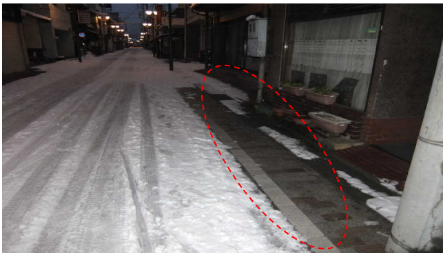
図-5 花里地区の融雪（タイル貼り舗装）
