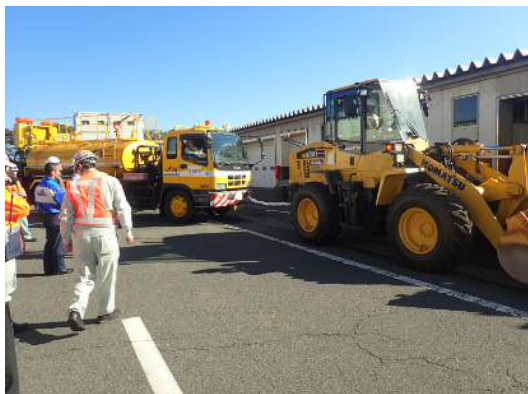
写真5 スタック車両（大型）の牽引訓練状況
