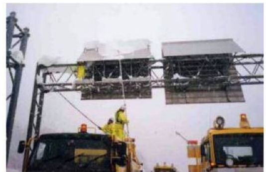
写真4 標識の着雪対策（過去写真）
