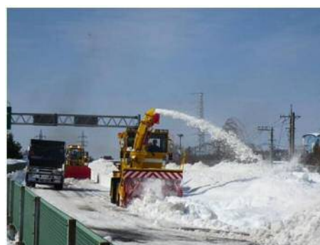
写真9 平成26年2月21日10:45頃 東富士五湖道路 河口湖IC付近 ロータリー除雪車による作業状況
