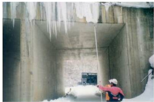
写真3 ボックス部のつらら落とし（過去写真）
