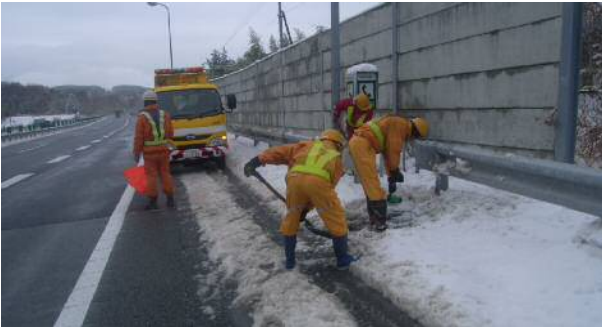
写真11 小淵沢IC付近の人力除雪状況
