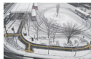
下水熱交換方式(管底設置型)融雪システム採用 (新潟市役所前バスターミナル歩道)
