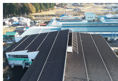
消雪シート施工面積4600㎡を差込方式により融雪、冷却 屋根面積を4分割し、各区画毎に時間差を設け500リットル/分を散水 施工は平成24年9月、空撮は平成29年11月実施
