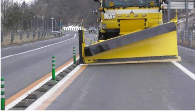
写真-6 ゴム板作業状況（前方）
