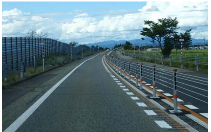
写真-2 中央分離帯ワイヤロープ設置状況
