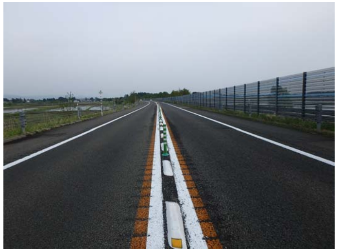
写真-1 暫定2車線区間
