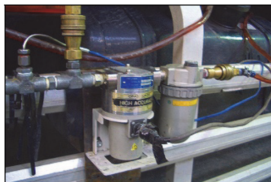
写真-2 燃料タンク脇に設置した流量検出器
