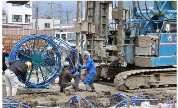
写真4 地盤改良機(杭打ち機)利用でのWUチューブ攪拌圧入
