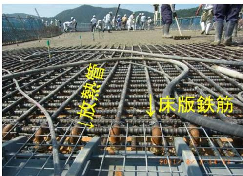
写真3 RC床版と融雪放熱管の融合(放熱管上面まで通常コンクリート, 上面黒着色鋼繊維補強コンクリートのwet on wet 打設(上中IC橋))
