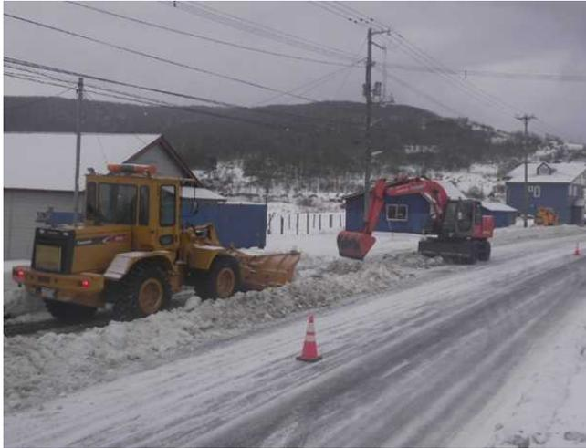
写真－３ バックホウとドーザによる巻き出し作業状況
