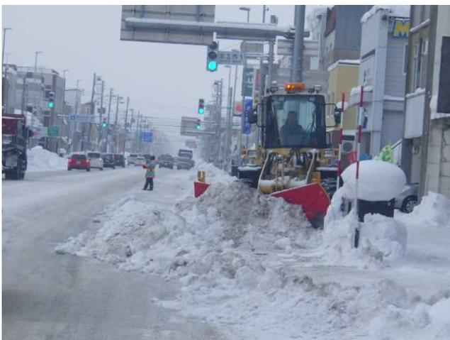
写真-11 ドーザによる構造物周辺の除雪状況
