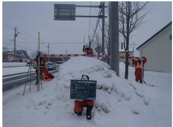
写真－５ 運搬排雪作業前の堆雪状況測量
