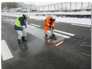
写真6 ポットホール緊急補修
