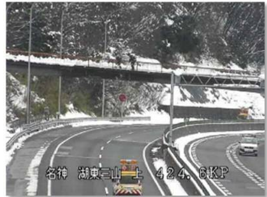
写真11 跨道橋上の雪庇落とし（自治体による作業）
