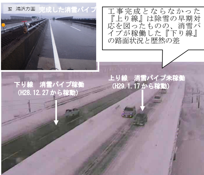
写真-1 完成した消雪パイプの稼働状況 H29.1.14(木) 場所：国道8号 新組跨線橋
