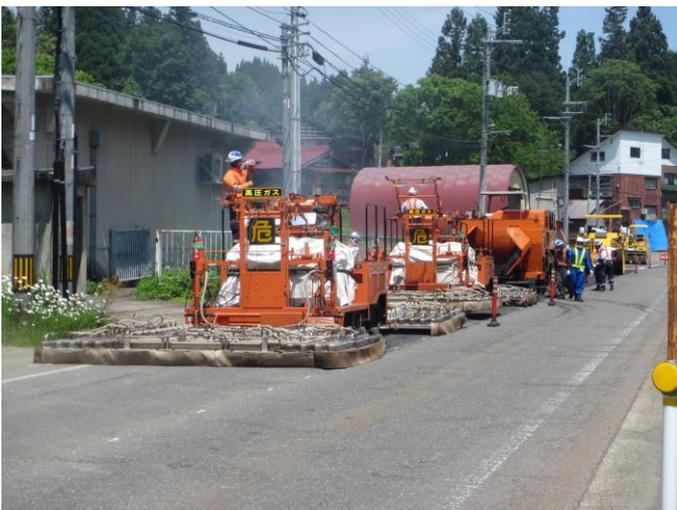
写真-6. 路上再生工法（ヒートドレッシング工法）
