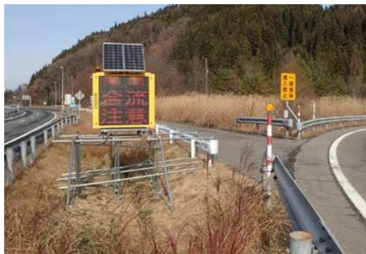
写真7 高速道路上の簡易LED情報板
