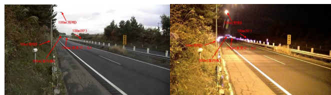
写真1 目標物の設定状況及び昼間(左)と夜間(右)の目標物の見え方(一例)
