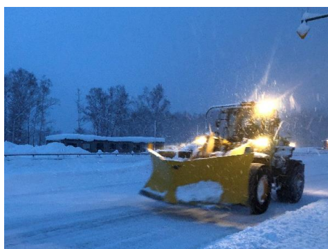
写真-1 施工箇所の冬期路面管理状況
