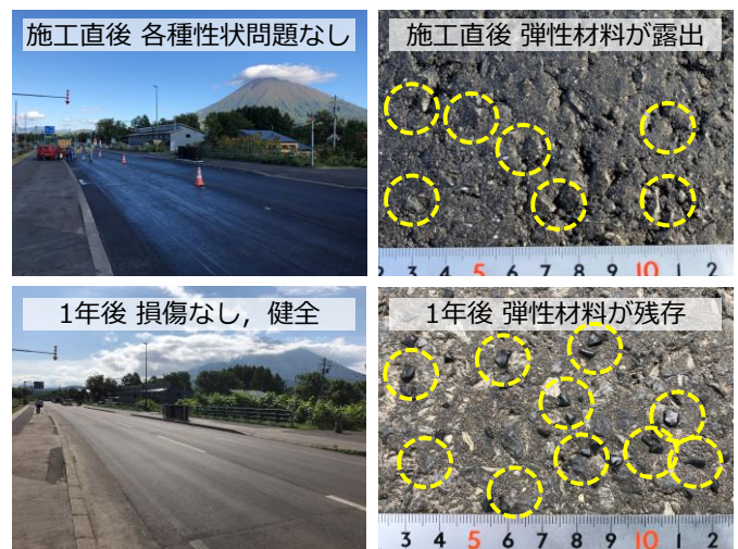
写真-8 施工直後と1年後の施工箇所
