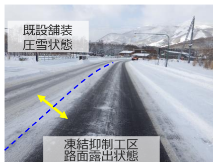
写真-4 2019年12月25日 10時08分撮影の路面
