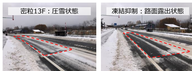
写真-3 2019年11月15日 8時10分撮影の路面
