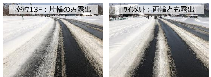
写真-7 2021年1月23日 12時55分撮影の路面
