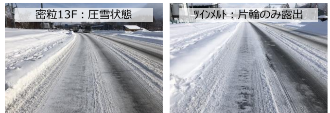
写真-6 2021年1月23日 11時40分撮影の路面
