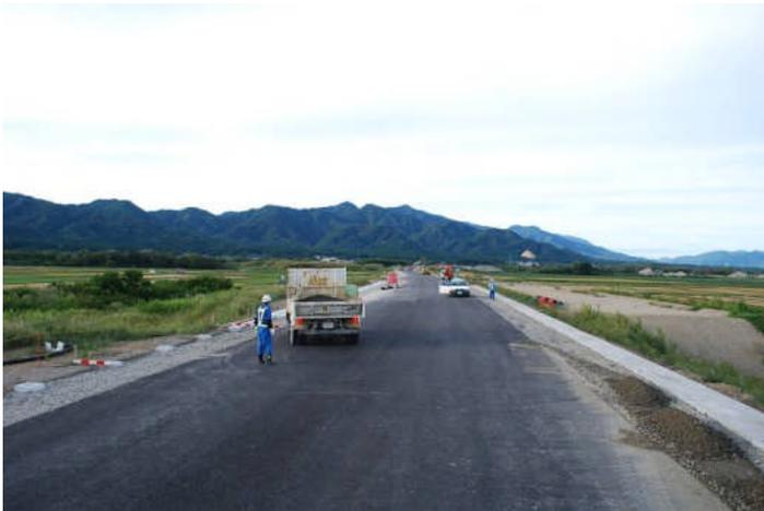
アスファルト安定処理が完了し、防護柵基礎及び路肩部の路盤工を施工している状況です。
