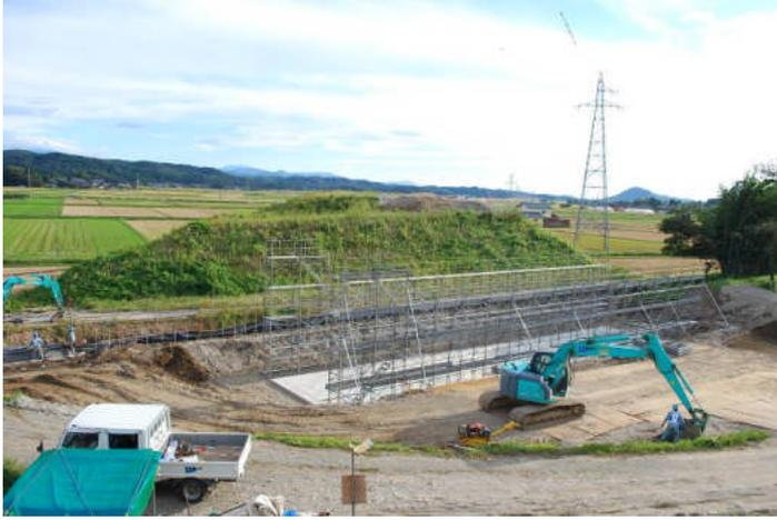
8月末に用地取得が完了し、9月に工事着手した市道ボックス設置箇所です。均しコンクリートが完了しています。この後、工場製作したプレキャストボックスを据え付け、道路本体盛土を施工します。
