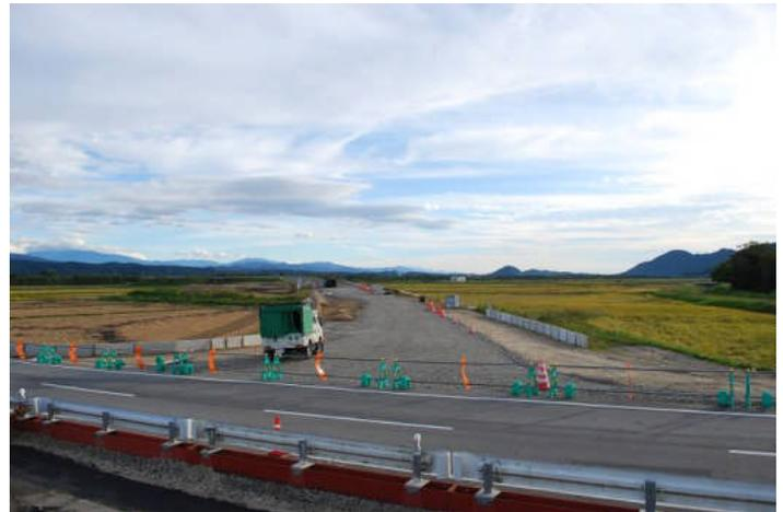
朝日まほろばICです。ここで県道小揚・猿沢線と接続します。擁壁工事、盛土工事が完了し、この後、路盤工・アスファルト舗装工を施工します。
