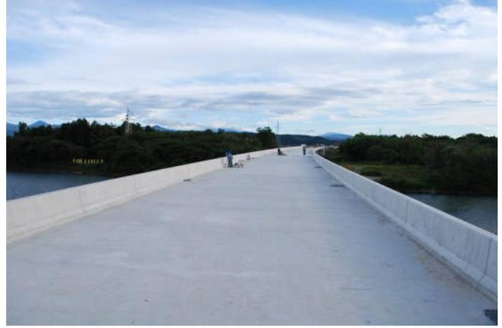
三面川に架かる橋梁上です。床版及び壁高欄が9月末に完了し、10月から防水層に着手しアスファルト舗装を進めます。
