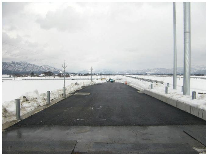
朝日三面ICのオフランプ部です。舗装工が完了しました。この後、ガードレール、区画線を施工します。(1月24日撮影)
