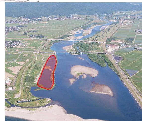
河道掘削状況(撮影:R1.6)
