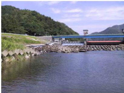
堰下流の河床洗掘による魚道の機能低下状況(荒川頭首工右岸)
