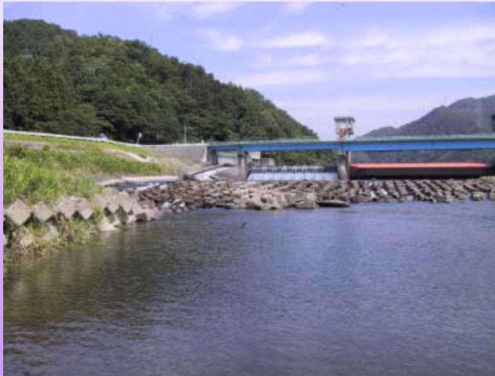
堰下流の河床洗掘による魚道の機能低下状況(荒川頭首工右岸)
