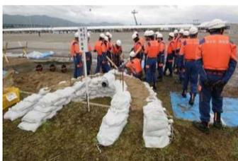
月の輪工【漏水対策】
