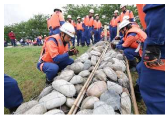
立蛇籠工【浸食対策】
