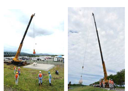
ブロック投入工及び大型土のう 投入工による応急復旧訓練
