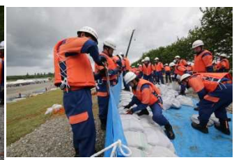
積み土のう工・改良積み土のう工【越水対策】
