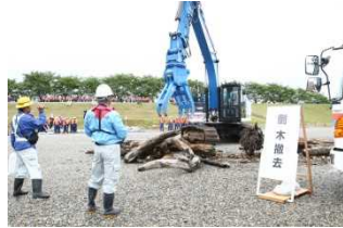
無人バックホウによる流木撤去作業
