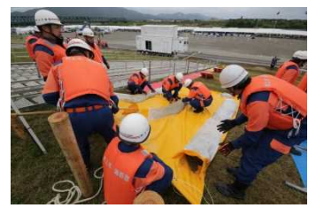
T型マット工 【浸食・漏水対策】
