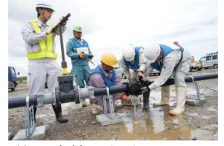
管工事協同組合によるライフライン復旧訓練
