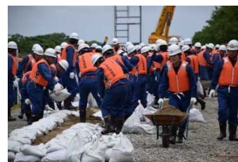
積み土のう工・改良積み土のう工【越水対策】
