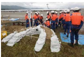
月の輪工【漏水対策】
