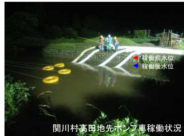
排水ポンプ車の支援
