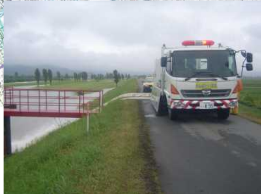
村上市鳥屋地先ポンプ車稼働状況
