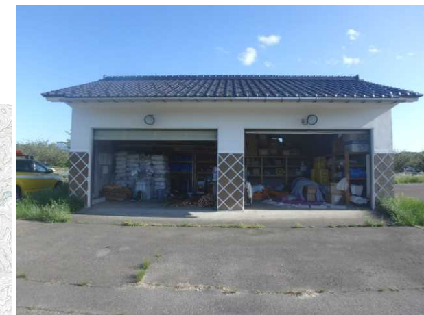
辰田新緊急資材備蓄倉庫(国)
