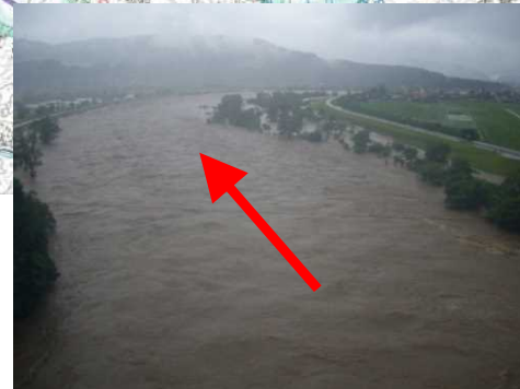
丸山大橋より下流を望む(6月23日17時頃)
