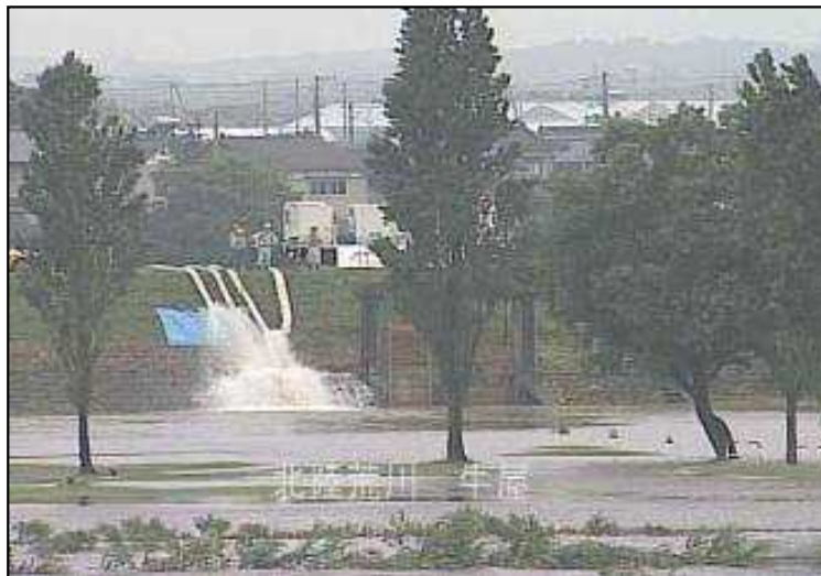
村上市鳥屋地先ポンプ車稼働状況
