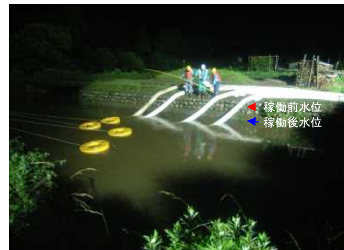
関川村高田地先ポンプ車稼働状況
