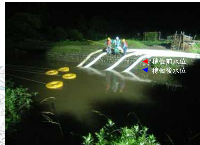
関川村高田地先ポンプ車稼働状況
