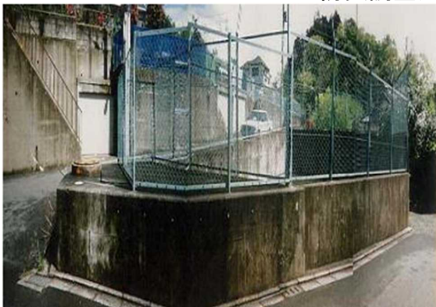
従前の防災調整池
