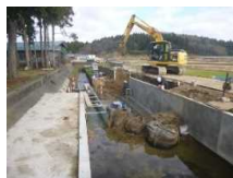
滝矢川改修【村上市】
