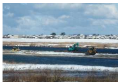
荒川河道掘削【羽越河国】
