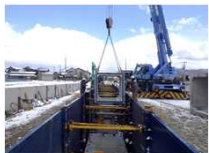
下水道雨水幹線整備【村上市】
