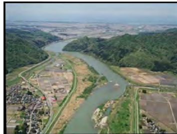
写真-3-6 河道掘削箇所（貝附地区）
