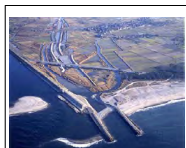
写真-3-4 乙大日川導流堤部閉塞状況
