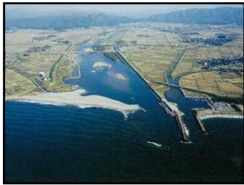
写真-3-5 河道掘削箇所（河口部）
