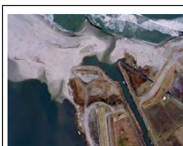
写真-3-3 堀川河口閉塞状況
