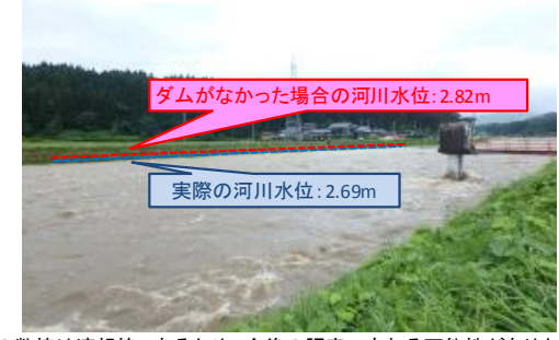
上川口水位観測所付近
